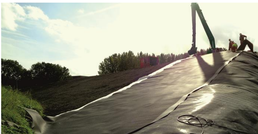
Foto: overzicht aanleggen IBC werk.
